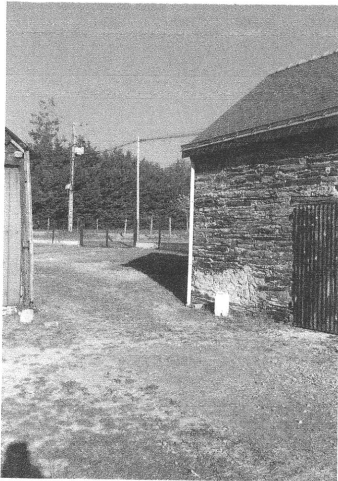
Vue du bâtiment avec en arrière- plan l'accès route par un portail
