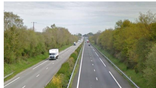
RN137, depuis le pont de Nozay
