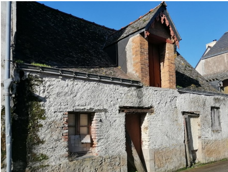
Habitation vacante à réhabiliter à Saffré (03.11.20)
