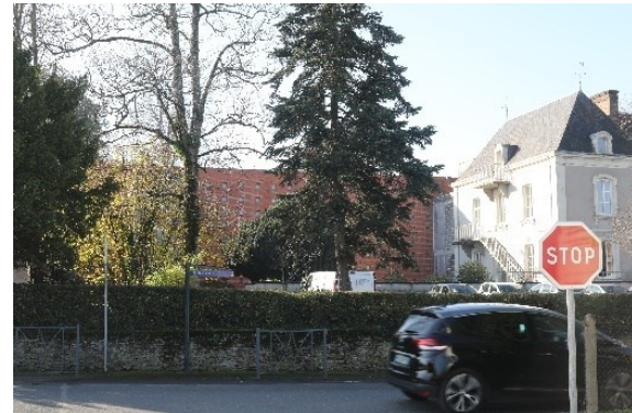
Centre hospitalier « La Chesnaie » à Nozay – 26.11.2020
