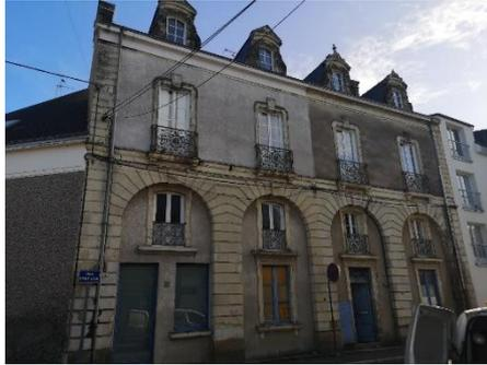
Transformation du rez-de-chaussée autrefois commerçant avec une modification de percement et un traitement de façade inadapté à la qualité de l'ensemble du bâtiment.
