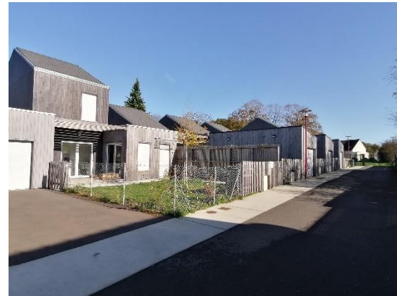
Opération Habitat 44 en densification (4) – 11.04.2020
