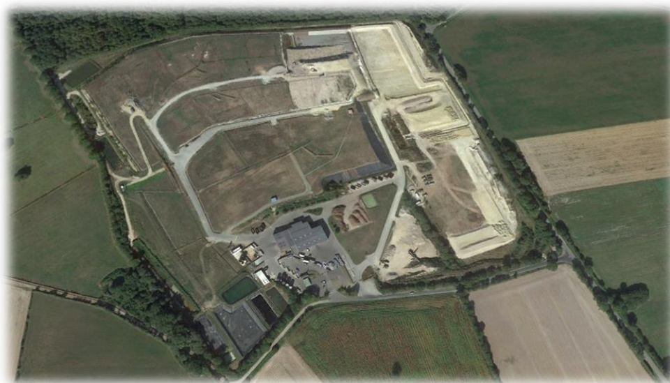
Photo aérienne de la déchèterie des Briulles, à Treffieux
