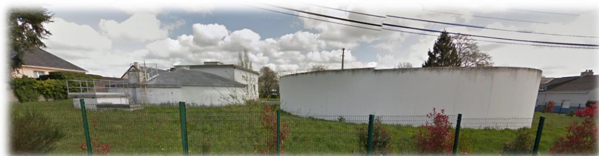
Photo des réservoirs situés sur Abbaretz
