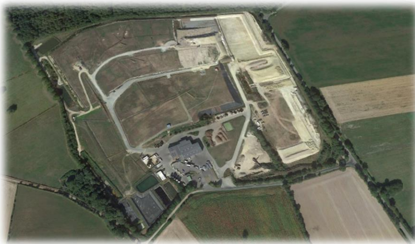
Figure 15 : Photo aérienne de la déchetterie des Briuelles, à Treffieux – DMEAU 2020
