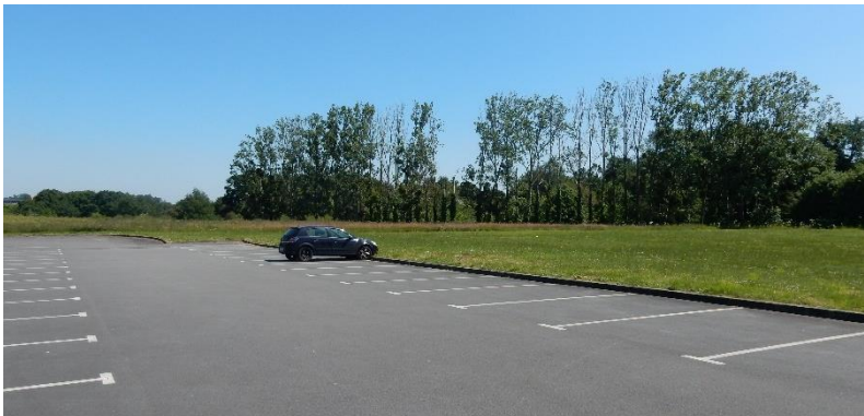
Vue sur les espaces de stationnement et alentours à l'Est
