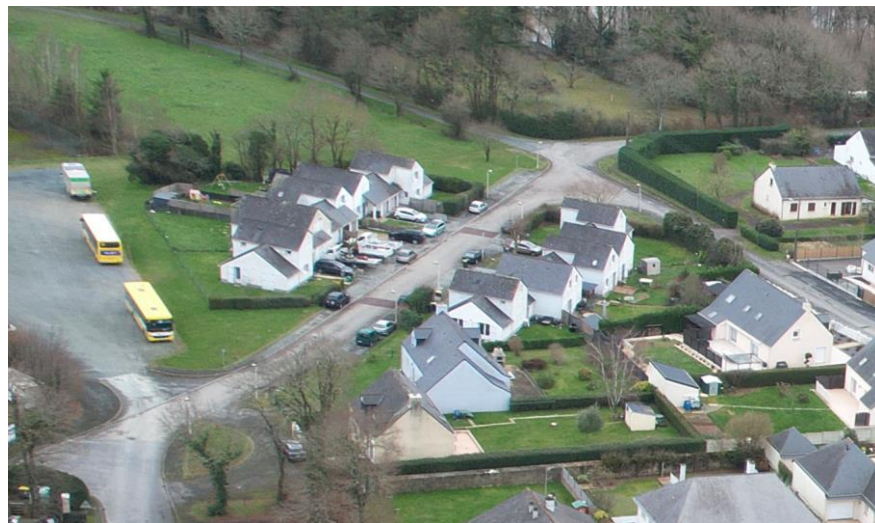
10 logements locatifs sociaux rue des Hauts du Port à Guenrouët
