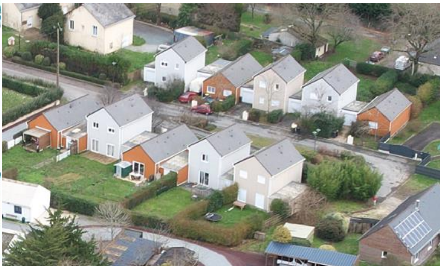
10 logements locatifs sociaux à Notre-Dame de Grâce
